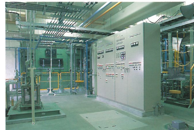
▲ 処理水槽上部室
